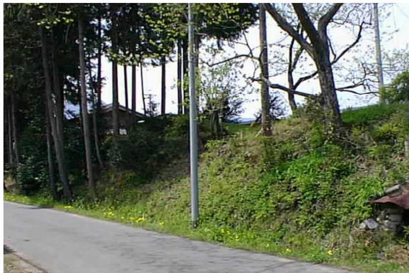
【Earthworks at Henkoji Temple Ruins】
